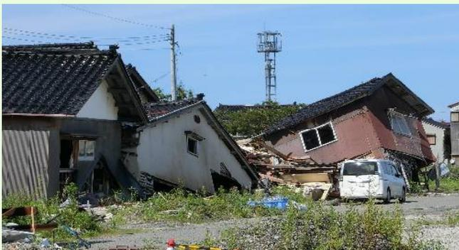
海岸近くでも倉庫のなど壁が多く矩形形状の建物には被害が出なく構造バランスが重要なのです。
