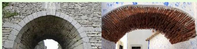
アーチは図のようにレンガを円弧の形状に並べただけで自重で強固に接着し、上からの力は両端下で横と下を押す力に変わっています。圧縮に強い石やレンガに適した構造です。
