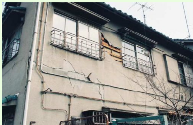
仕上げ材が脱落している
