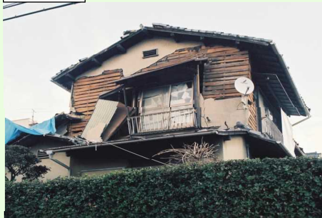
仕上げ材が脱落しており下地材にひび割れが生じている
