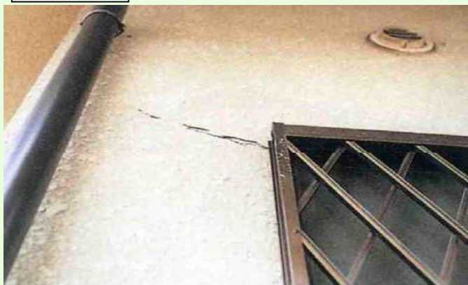
開口隅角部にわずかなひび割れが生じている
