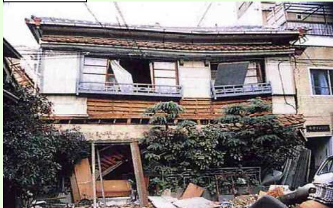
仕上げ材が脱落しており下地材に破損が生じている
