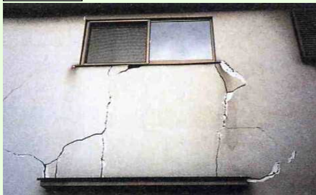
仕上げの剥離が生じている
